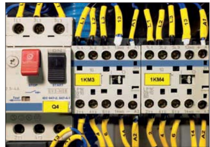
Marcador impreso libre de halógenos después de contraer.
